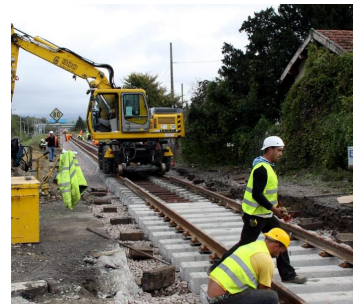
Figure 68 : Exemple de Train Travaux (Source : SNCF Réseau)
