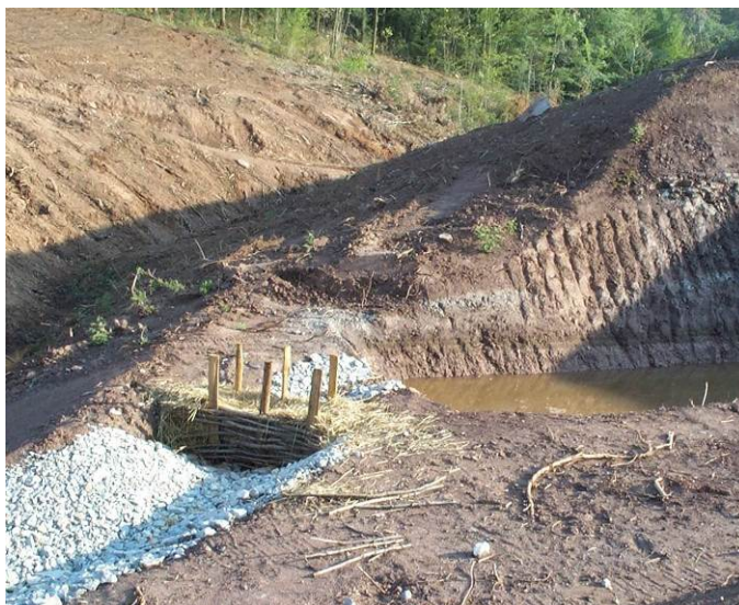
Figure 69 : Filtre à paille en sortie d'un bassin de décantation (Source : EGIS)
