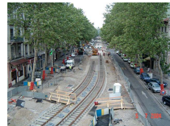
Figure 62 : mise en place des rails
