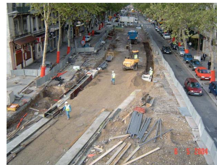
Figure 6 : Travaux de terrassement pour l'aménagement d'une ligne de tramway en zone urbaine
