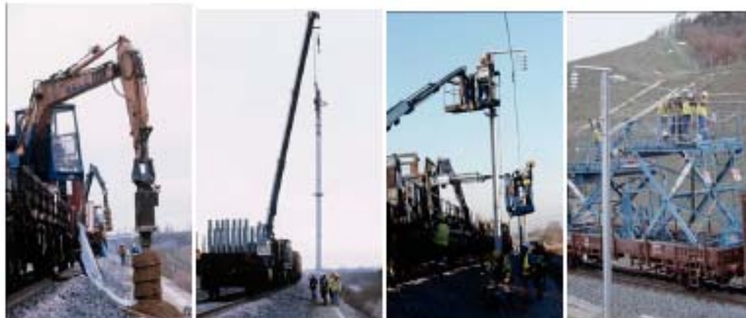
Figure 64 : les différentes étapes de pose de la LAC (Source : étude d'impact TGO1/étude d'impact TTNC)
